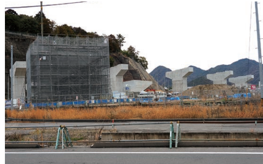
早期の完成が期待される岩国大竹道路の建設現場
