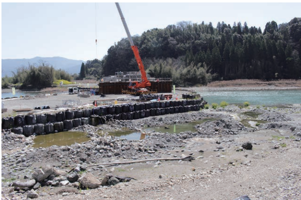
レールが引きちぎられ、橋桁ごと流失した「くま川鉄道・第四橋梁」の復興は令和7年度中の予定だ
