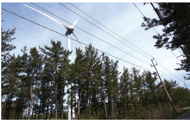
防風林の中に設置された「風の松原風力発電所」の風車。事業費の一部を市民ファンドで調達
