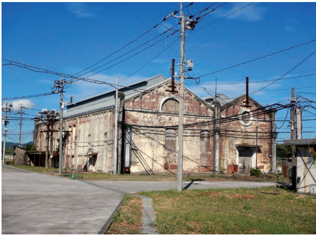
製鉄に必要な冷却用水などを安定的に確保するため明治43年に操業を開始し、今も現役の世界遺産「遠賀川水源ポンプ室」
