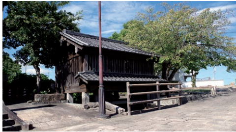
江戸時代初期、福岡藩初代藩主・黒田長政の命で遠賀川から水上輸送やかんがい用水確保のため開削された堀川の取水口「堀川の中間唐戸」(水門 / 県指定文化財)
