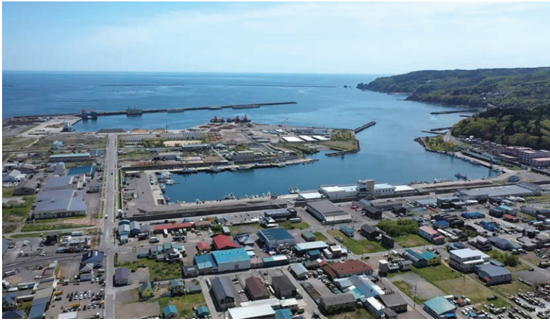
重要港湾・久慈港。「久慈港湾口地区防波堤整備事業」が国直轄で進められ、75%が概成済みで、現在沖合への浮体式洋上風力発電の導入を目指している
